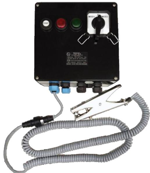
Exemplo de monitor ativo intrinsecamente seguro para aterramento de caminhões com intertravamento de início de operação
