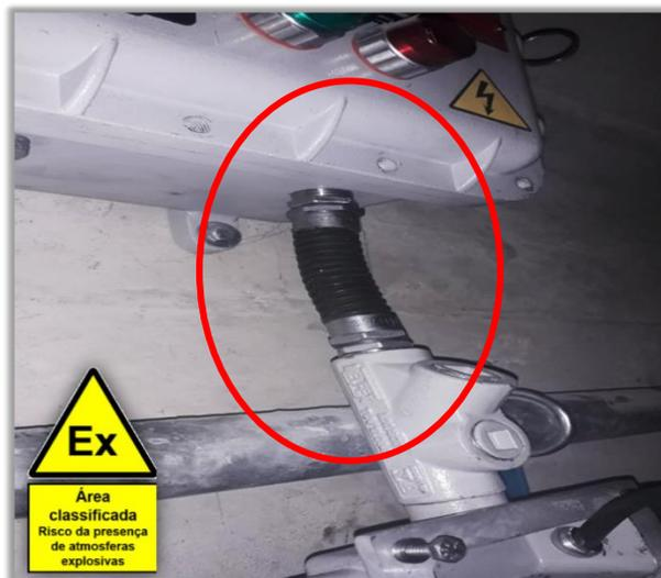
Exemplo de indevido desvio “Ex”: Invólucro metálico com certificação Ex “d” encontrado instalado em campo, em área classificada, com a conexão direta de eletroduto flexível com capa da PVC
