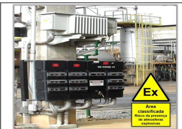
Exemplo de detalhe típico de projeto para montagem de painel de distribuição “Ex” para circuitos de força e controle com tipo de proteção “segurança aumentada” e componentes centelhantes “à prova de explosão com invólucro plástico”. Exemplo de marcações: Ex dem IIC T5 Gb / Ex tb IIIC T100 °C Db. Transformador trifásico com tipo de proteção “segurança aumentada” ou Ex “t”. Exemplo de marcações: Ex ec IIC T4 Gc / Ex tb IIIC T135 °C Db
