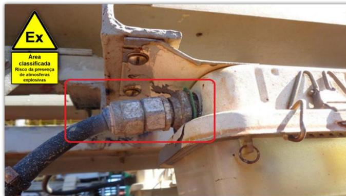
Luminária do tipo “segurança aumentada”, com certificação Ex “e” encontrada em área classificada com prensa-cabo sem aperto, com ingresso de água para o interior do invólucro
