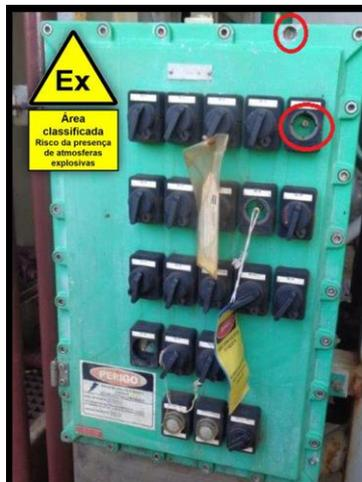
Exemplo de painel elétrico com invólucro metálico com certificação do tipo “à prova de explosão” encontrado instalado em área classificada com parafuso de fixação da tampa quebrado e chave de controle sem o eixo de vedação
