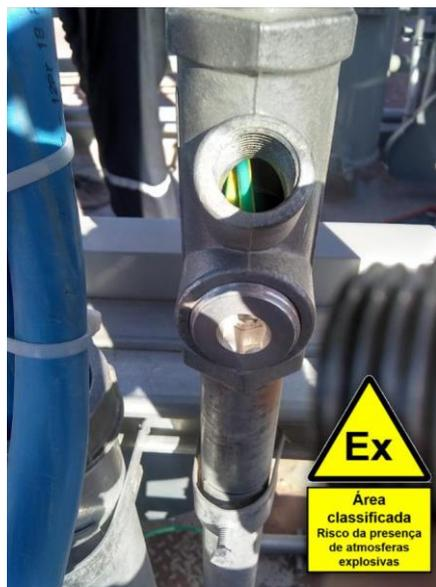
Exemplo de unidade seladora de eletroduto com certificação do tipo “à prova de explosão” encontrada instalada em área classificada sem enchimento interno (vazia)
