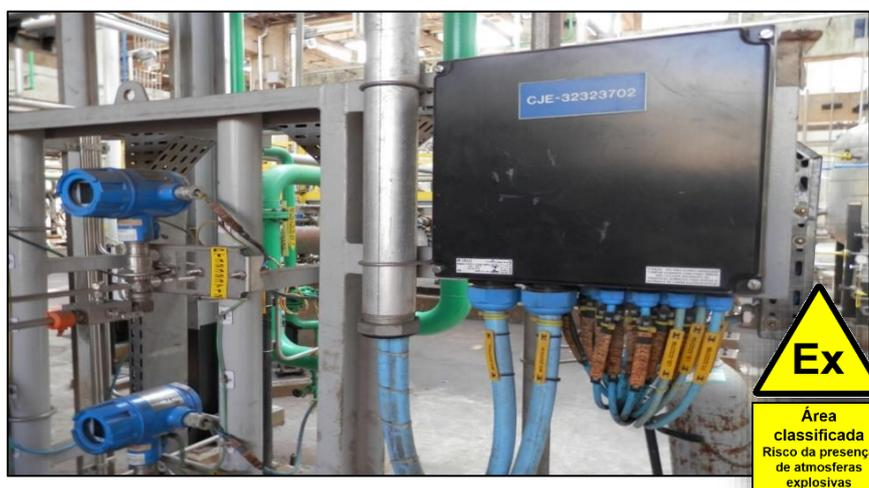
Exemplo de instalação de instrumentos transmissores, caixas de Junção Ex "e" com circuitos Ex "i" na cor azul clara
