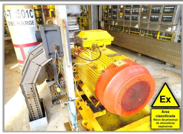
Exemplo de detalhe típico de projeto para montagem de motor de indução trifásico com marcações Ex “eb”, Ex “ec” ou Ex “tb”. Forma construtiva IM B3T (Norma ABNT NBR IEC 60034-7) e botoeira local de comando com marcações: Ex db eb IIC T6 Gb / Ex tb IIIC T85°C Db
