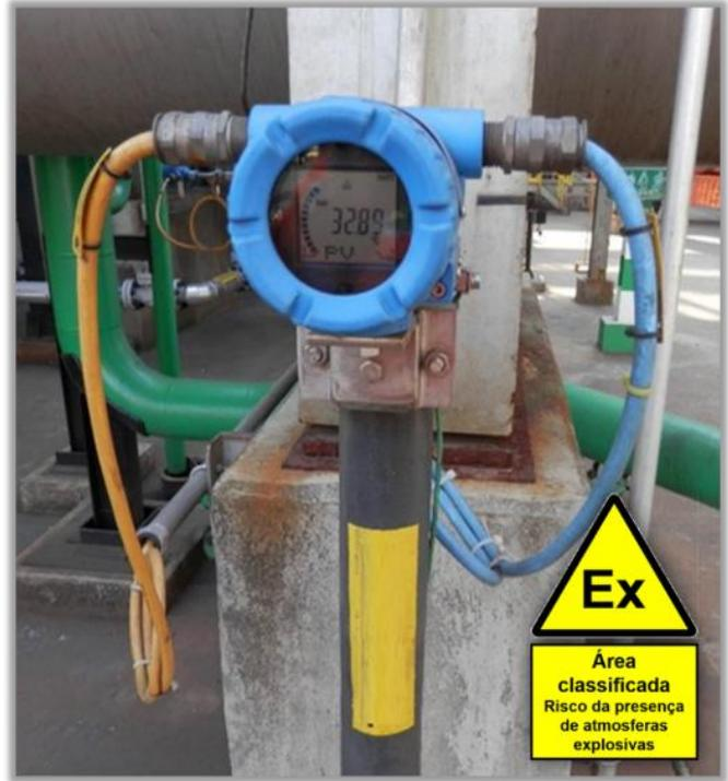
Exemplo de detalhe típico de projeto para montagem de instrumentos sensores e transmissores com marcações Ex “ib”, Ex “db”, Ex “em” ou Ex “tb”. Entrada de cabo do tipo não armado (Zona 2/22) por meio de prensa-cabos Ex “d” ou Ex “t”
