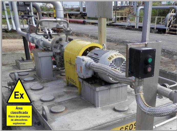
Exemplo de detalhe típico de projeto para montagem de motor de indução trifásico com marcações Ex “eb”, Ex “ec” ou Ex “tb”. Forma construtiva IM B3L (Norma ABNT NBR IEC 60034-7) e botoeira local de comando com marcações: Ex de IIC T6 Gb / Ex tb IIIC T85°C Db
