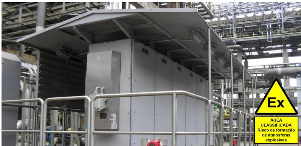
*Exemplo de instalação de painel pressurizado (Ex “pzc”) contendo unidade terminal remota de SDCD e PLC*
