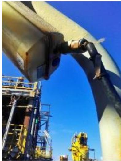
Exemplo de luminária com invólucro metálico com certificação do tipo “*segurança aumentada*” encontrada instalada em área classificada com dano na fixação do prensa-cabo. Pode ser observado também que o cabo está com a blindagem exposta na saída do prensa cabos (Norma ABNT NBR IEC 60079-17 – Itens de verificação T1-A11 e T1-B02), possivelmente por efeito de tração no cabo
