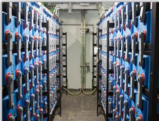
De acordo com a Norma Regulamentadora NR-37 é requerida a instalação de **detectores de hidrogênio** no interior da sala de bateria de acumuladores, de forma a alarmar, no sistema supervisor, a presença indevida deste gás inflamável, por exemplo em uma concentração acima de 20 % de seu LIE.
