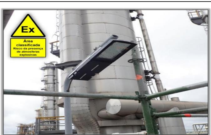
Exemplo de detalhe típico de projeto para montagem de luminárias “Ex” LED. Exemplo de marcações: Ex d e m op q IIC T5 Gb / Ex tb IIIC T100°C Db, Ex nC nR IIC T5 Gc / Ex tb IIIC T100°C Db
