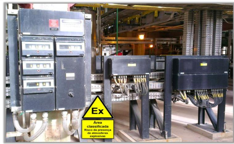
Exemplo de montagem de painel de distribuição “Ex” para circuitos de força e controle com tipo de proteção “segurança aumentada” e componentes centelhantes “à prova de explosão com invólucro plástico” ou Ex “t”.
