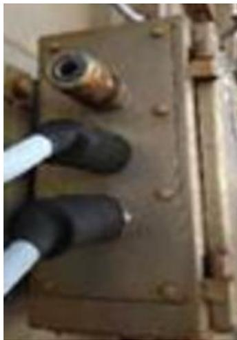
Exemplo de painel elétrico com invólucro metálico com certificação do tipo “segurança aumentada” encontrado instalado em área classificada com instalação de prensa cabo, porém sem o cabo instalado
