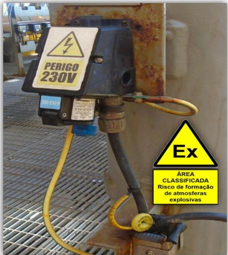
Exemplo de detalhe típico de projeto para montagem de TOMADA DE FORÇA “Ex” com tensão nominal de 230 V ou 480 V, com tipo de proteção “segurança aumentada” e componentes centelhantes “à prova de explosão com invólucro plástico” ou Ex “t”. Exemplo de marcações: Ex IIC T4 Gb / Ex tb IIIC T135 °C Db
