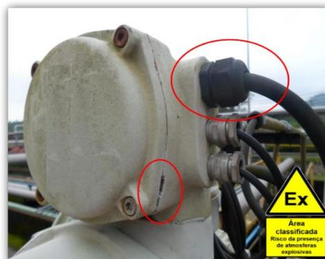
*Exemplo de “normalização de desvios Ex”: Acionador elétrico de válvula de bloqueio motorizada, com invólucro metálico certificado “à prova de explosão”, encontrado com sinal de dano ao invólucro devido à necessidade de utilização de talhadeira e marreta para abertura da tampa e instalação incorreta de prensa-cabo Ex “e” de material plástico*
