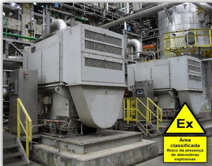
Exemplo de instalação de motores com tipo de proteção Ex "pzc" – Invólucro Pressurizado – Norma
