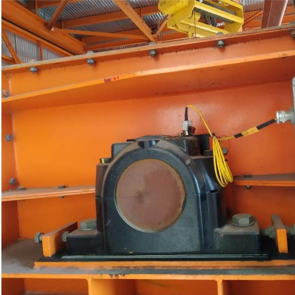
Sensor de temperatura instalado em mancal de rolamentos de esteira transportadora contendo poeiras combustíveis
