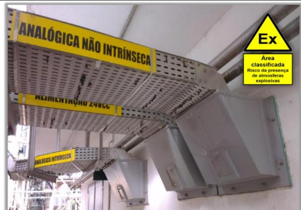
Exemplo de montagem de distribuição de cabos em áreas classificadas por meio de sistema de bandejamentos e leitos
