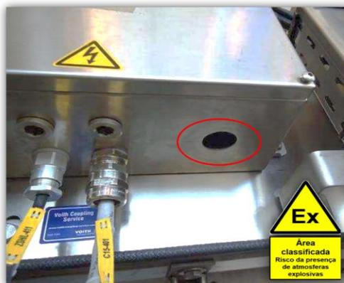
Exemplo de indevido desvio “Ex”: Caixa de terminais (“Junction-Box”) com certificação Ex “e” (segurança aumentada) encontrada instalada no campo, em área classificada, com entrada de cabos não utilizada aberta (sem bujão “Ex”)
