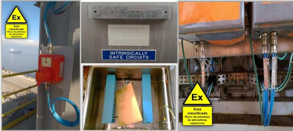
Equipamentos intrinsecamente seguros, com certificação Ex “i”, encontrados instalados em área classificada, conectado a caixas de junção com cabos com capa externa na cor “azul claro”, sem a instalação de barreira de segurança intrínseca ([Ex “i”]) para a proteção dos respectivos circuitos
