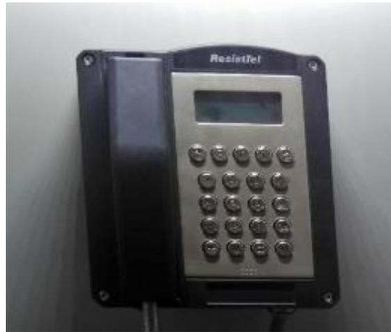
Exemplo de equipamento **sem certificação** “Ex” instalado em área classificada
