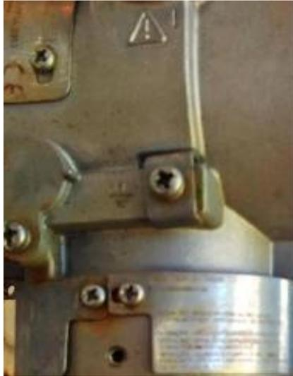
Exemplo de equipamento “Ex” sem a instalação de cabo de aterramento ou de equipotencialização
