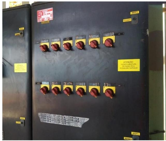
Painel local de controle contendo internamente **componentes centelhantes** em invólucro **plástico** Ex “d” e terminais de segurança aumentada Ex “e”: chaves de comando. Tipos de proteção combinados **Ex “de”**. Invólucro externo em poliéster reforçado com fibra de vidro ou outros materiais **plásticos**
