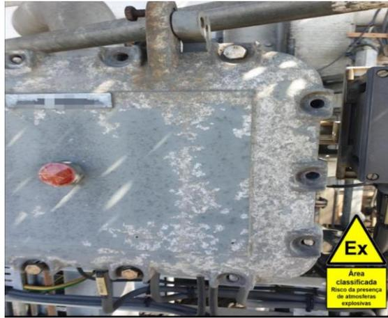
Exemplo de painel elétrico com invólucro metálico com certificação do tipo “à prova de explosão” encontrado instalado em área classificada com falta de parafusos de fixação da tampa
