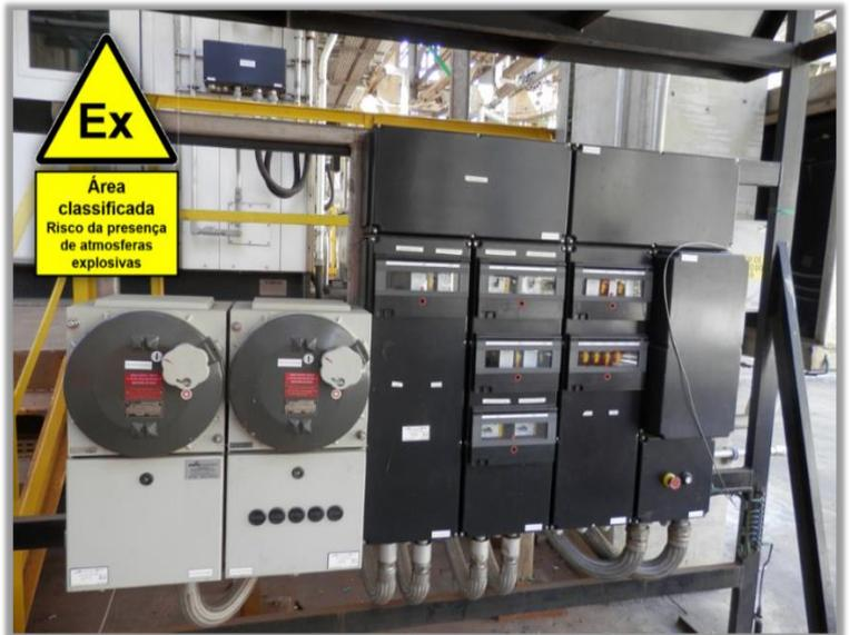
Exemplo de detalhe típico de projeto para montagem de Painel de distribuição “Ex” de circuitos de força e controle, com invólucro metálico do tipo de proteção “à prova de explosão”. Exemplo de marcações: Ex de IIC T4 Gb / Ex tb IIC T135 °C Db. Tampas **ROSCADAS** e entradas **INDIRETAS** de cabos por meio de caixa de terminais do tipo “segurança aumentada” (Ex “e”)
