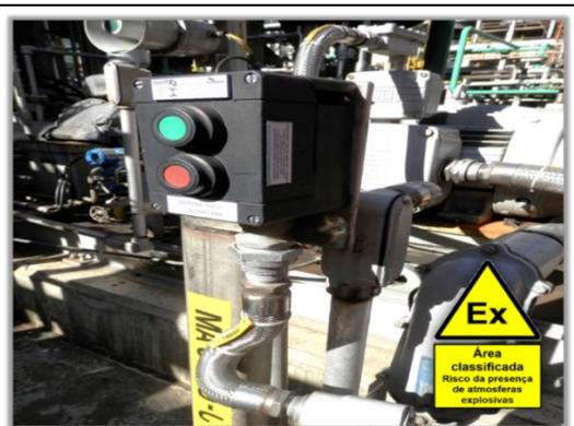
Exemplo de montagem de botoeira local de comando Ex “dem”. Ao fundo, exemplo de instalação de motor de indução trifásico com marcações Ex “eb”, Ex “ec” ou Ex “tb”
