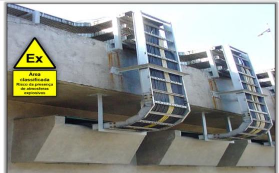
Exemplo de montagem de CAIXAS DE AREIA para passagem de cabos para circuitos de elétrica, instrumentação, automação ou telecomunicações em FRONTEIRAS entre áreas CLASSIFICADAS e áreas NÃO CLASSIFICADAS
