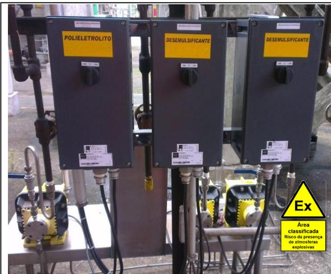
Exemplo de montagem de painel “Ex” para distribuição circuitos de força e controle, com tipo de proteção “segurança aumentada” (Ex “e”) e componentes centelhantes “à prova de explosão” ou “encapsulados” com invólucro plástico (Ex “db eb mb”) ou Ex “t”
