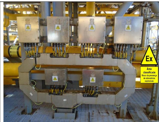
Exemplo de montagem de caixas de junção Ex “e”, com invólucros em chapas de aço inoxidável, para distribuição de circuitos controle e automação, com tipo de proteção “segurança aumentada” ou Ex “t”. Exemplo de marcações: Ex eb IIC T5 Gb / Ex tb IIIC T100 °C Db
