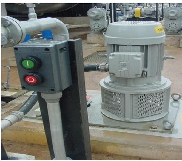
Botoeira local de comando para acionamento de motor “Ex”, contendo internamente **componentes centelhantes** em invólucro **plástico** Ex “d” e terminais de segurança aumentada Ex “e”. Tipos de proteção combinados Ex “de”. Invólucro externo em poliéster reforçado com fibra de vidro ou outros materiais **plásticos**
