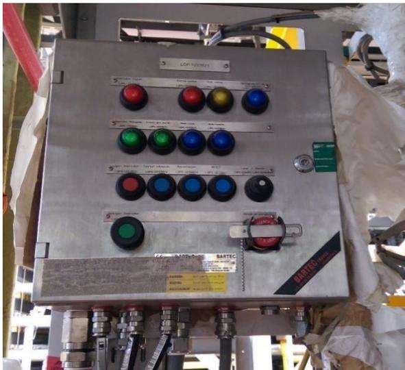
Painel local de controle contendo internamente **componentes centelhantes** em invólucro **plástico** Ex “d” e terminais de segurança aumentada Ex “e”: botões de comando, sinaleiros LED e chave de comando. Tipos de proteção combinados Ex “de”. Invólucro externo em chapas de **aço inoxidável**
