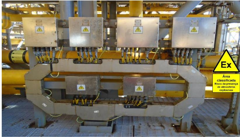
*Exemplo de caixas de terminais (“Junction-Boxes”) com invólucros **metálicos**, em aço inoxidável, com tipo de proteção Ex “e” (segurança aumentada), com requisitos de serviços de campo simplificados, sem a necessidade de instalação de unidades seladoras, niples ou uniões macho/fêmea com tipo de proteção Ex “d”*
