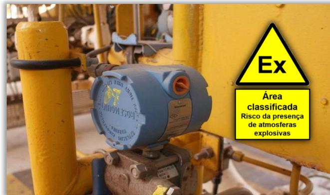
Exemplo da indevida “normalização de desvios Ex”: Instrumento com certificação Ex “d” encontrado com entrada de cabo não utilizada plugueada indevidamente com tampão plástico para proteção de rosca (sem bujão “Ex”)
