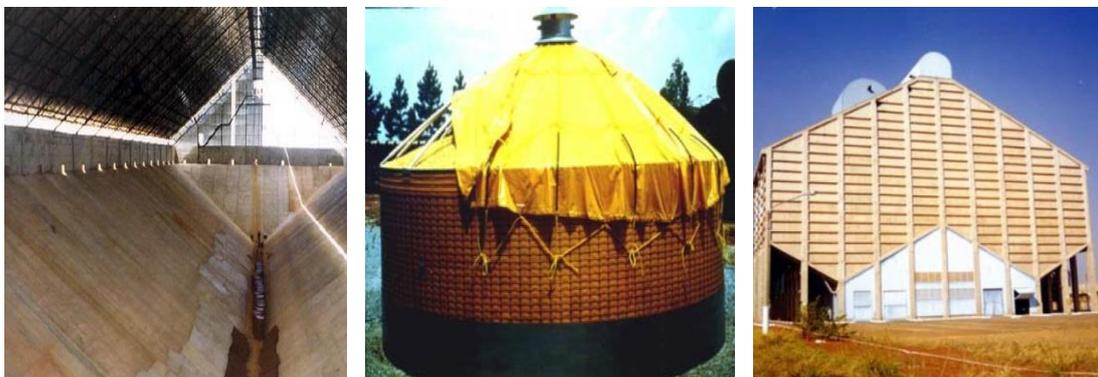
Tipos de silo: Pré- moldados de concreto, em tela metálica e tecido e horizontal semisubterrâneo. Fonte: Calil Junior; Cheung 2007
