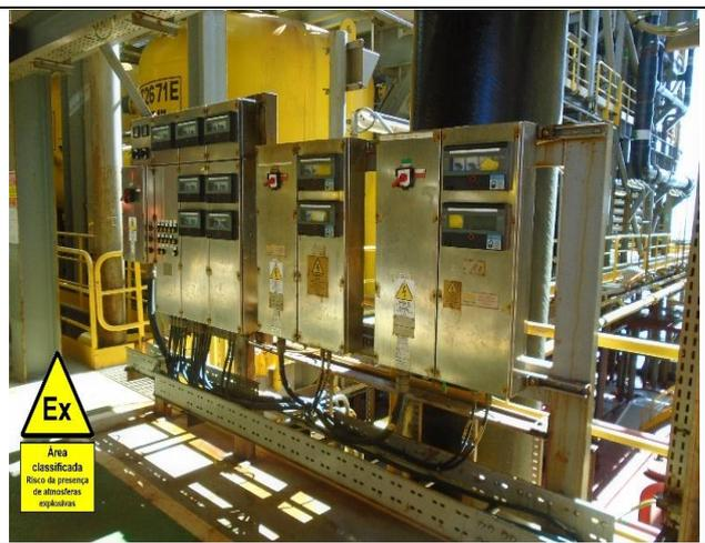
Exemplo de montagem de painéis de distribuição “Ex”, com invólucros em chapas de aço inoxidável, para circuitos de força e controle, com tipo de proteção “segurança aumentada” e componentes centelhantes “à prova de explosão com invólucro plástico” ou Ex “t”
