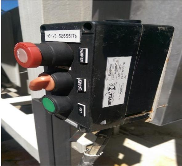
Botoeira local de comando contendo internamente **componentes centelhantes** em invólucro **plástico** Ex “d” e terminais de segurança aumentada Ex “e”. Tipos de proteção combinados Ex “de”. Tipos de proteção combinados Ex “de”. Invólucro externo em poliéster reforçado com fibra de vidro ou outros materiais **plásticos**
