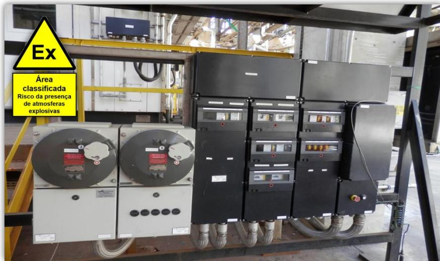
Exemplo de instalação de painéis de distribuição de força e controle instalado em área classificada –
