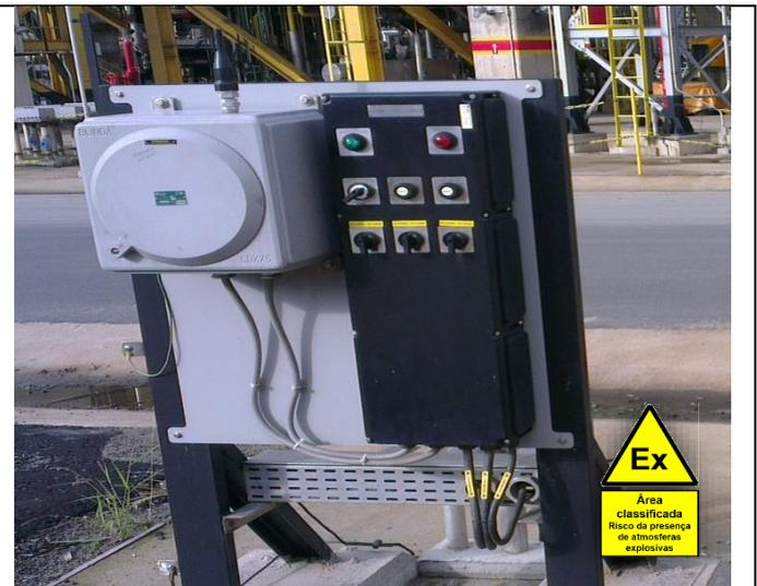
Exemplo de montagem de painel “Ex” para distribuição circuitos de força e controle, com tipo de proteção “segurança aumentada” (Ex “e”) e componentes centelhantes “à prova de explosão com invólucro plástico” (Ex “db eb mb”) ou Ex “t”
