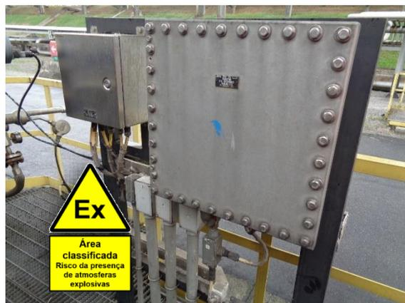
*Exemplo de caixa de terminais (“Junction-Box”) com invólucro metálico do tipo “à prova de explosão”, com junta flangeada, com a necessidade de instalação e aperto de grande quantidade de parafusos para a fixação da tampa*
