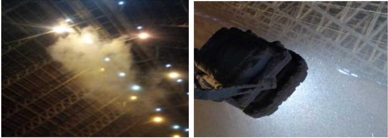
Exemplo de nuvem de poeira em expansão e em contato com refletores com tipo de proteção Ex “t”
