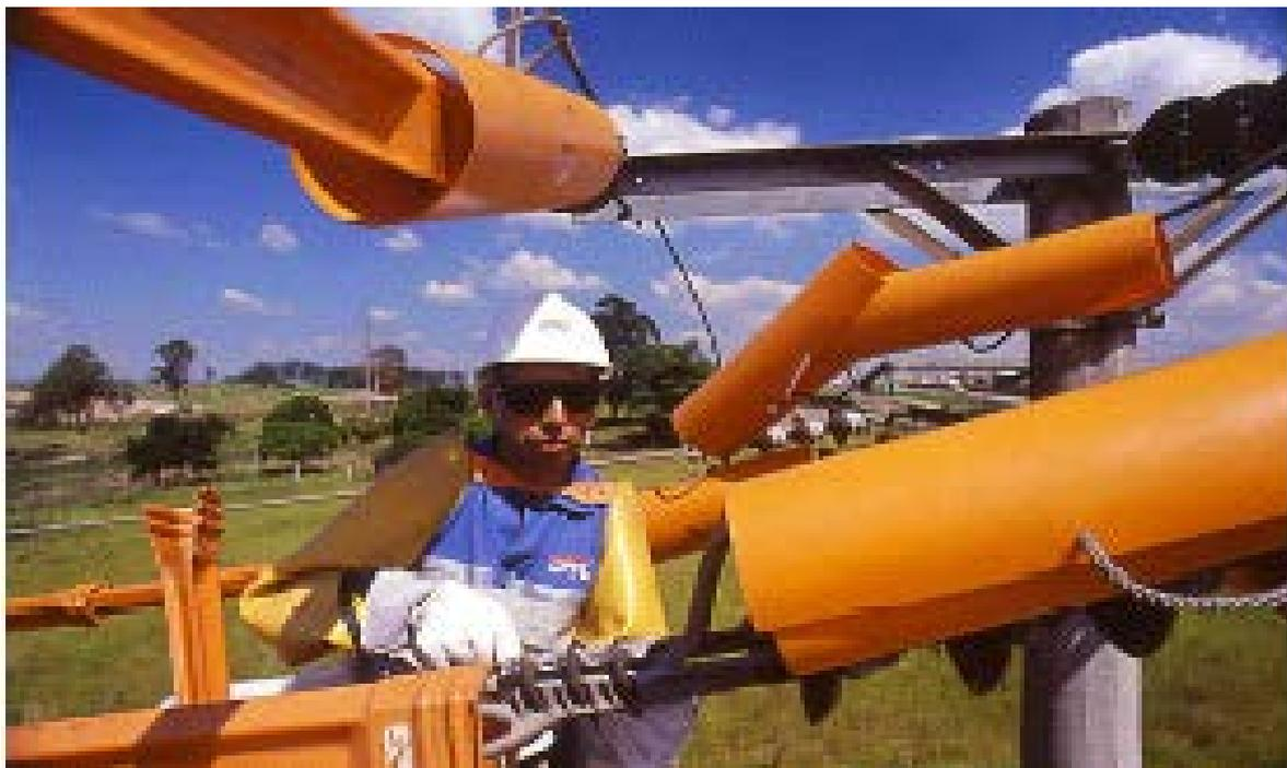
Figura 23– Isolação das partes vivas de linha energizada
