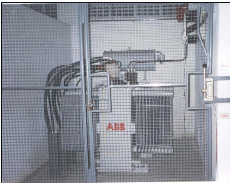
**14.3. INVÓLUCROS** – Envoltórios destinados a impedir todo e qualquer contato com partes internas energizadas.
