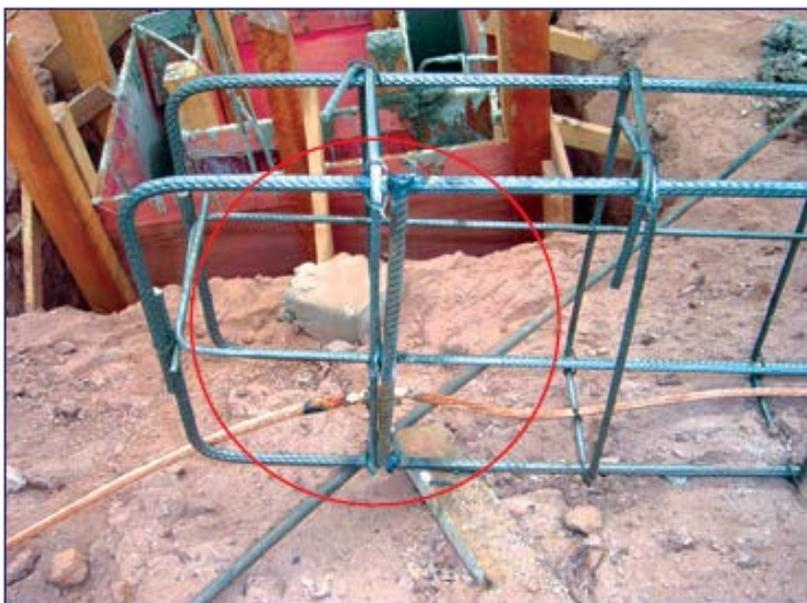
Figura 61 – Conexão de cabo de aterramento de 50 mm<sup>2</sup> com armadura de baldrame, utilizando solda exotérmica.
