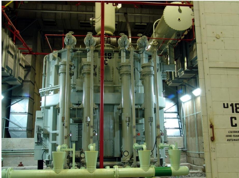
Figura 79 – Subestação Abrigada de Itaipu (interna) blindada em gás Hexafluoreto de Enxofre (SF6)
