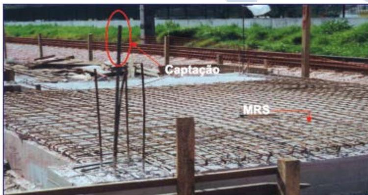
Figura 63 – Sistema de captação via armaduras e malha de referência de sinal (MRS) interligada com as ferragens do piso, para gerar um plano de referência de terra o mais equalizado possível.
