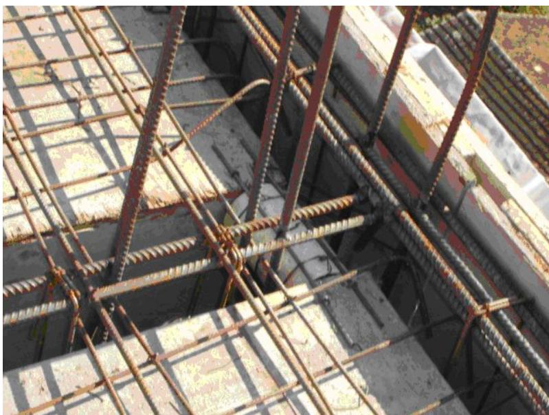
Figura 64 – Solda entre ferragem vertical, horizontal e a malha de ferro da laje.
