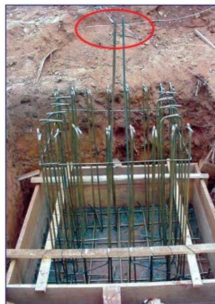
Figura 62 – Armaduras das fundações preparadas para a interligação das ferragens dos pilares
